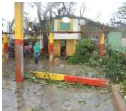
Nach dem Hurrikan: Halle und Dächer sind komplett zerstört, Bäume liegen am Boden, alles ist durchnässt.
