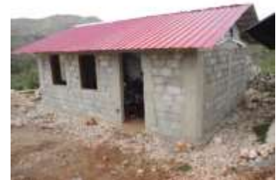
Vorschulgebäude, das durch das Crowdfunding finanziert wurde. Es hielt dem Hurrikan stand.
